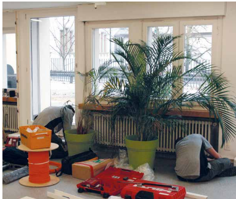
Hier entstehen 4 Arbeitsplätze für angehende Mediamatiker
